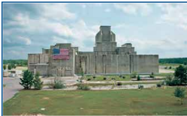
Рис. 1.49. Здание реактора Р, помещенное в «коккон» из бетона
