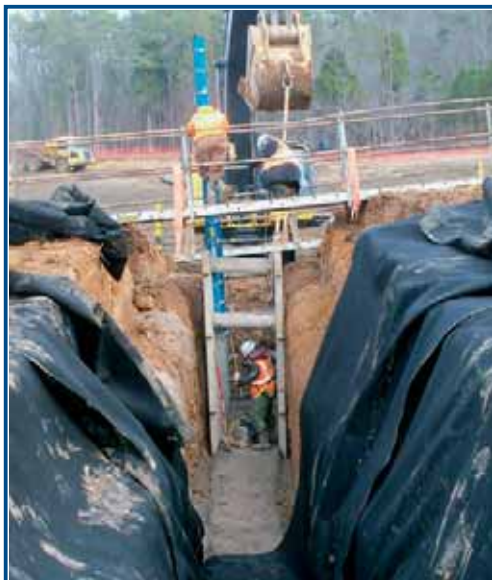
Рис. 1.17. Работы по сооружению гидроизоляционного барьера
