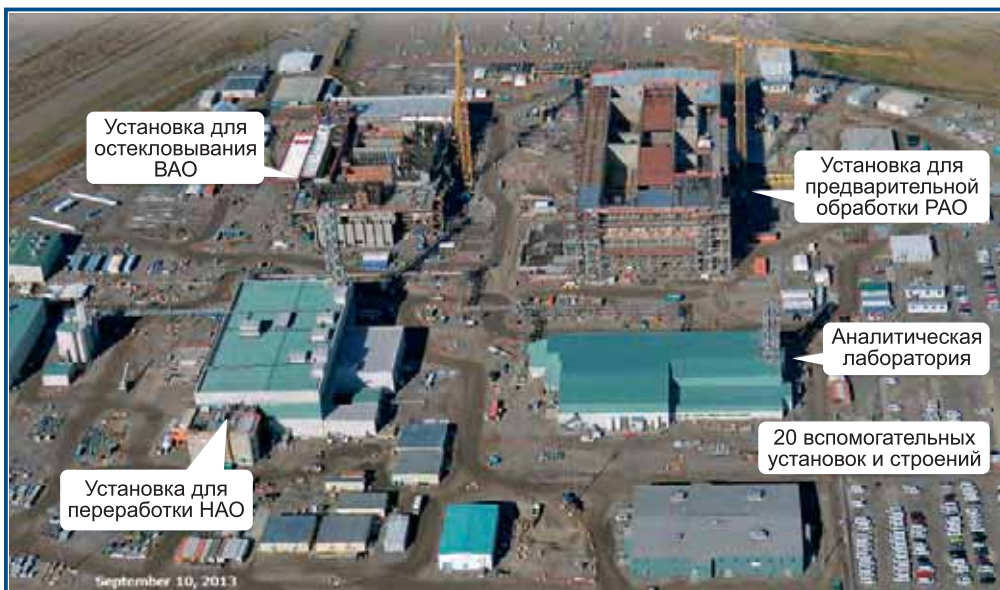
Рис. 1.41. Завод по переработке ЖРО
