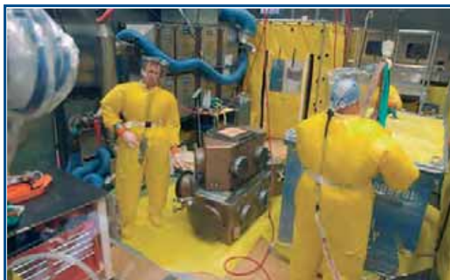
Рис. 1.18. Работы с ТРУ РАО, допускающими контактное обращение
