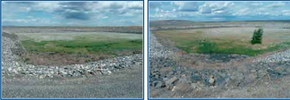
Рис. 1.43. Промышленные водоемы выдержки ЖРО, являющиеся частью установки TEDF (пруд А и пруд В)
